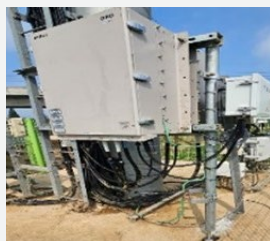
장비 받침대 설치
