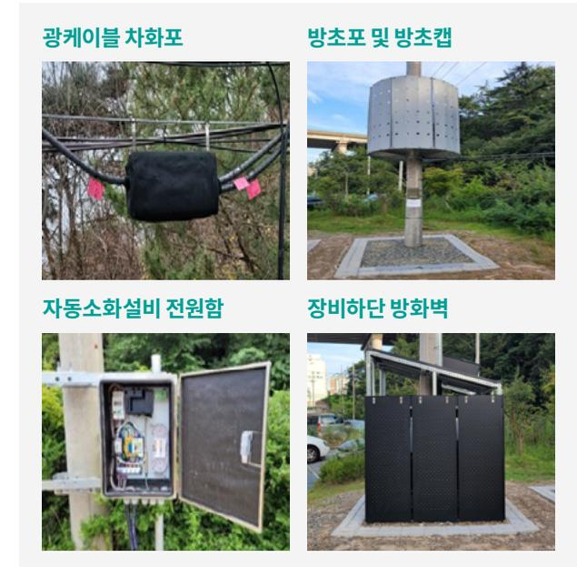
SK텔레콤은 무선 통신설비에 산불로 인한 화재가 발생하지 않도록 화재발생 요인을 원천 차단하고 있습니다. 전원함 내부에는 자동소화 설비와 난연 소화포를 부착하였고, 통신주 하단에는 방초포와 방초캡을 설치하였습니다. 또한, SK텔레콤은 산불 발생 취약지역 내에 위치한 무선 통신설비를 보호하기 위해 케이블 난연화, 카본 차화포, 열차단 테이프, 내열도로, 불연성 방화벽 등 방염과 내열성을 강화하였습니다.
